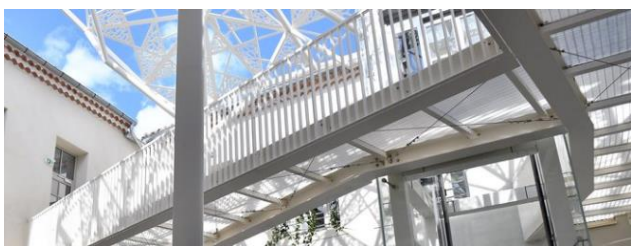
Pose d'un ascenseur extérieur sur un bâtiment historique. (CRD de Narbonne)
